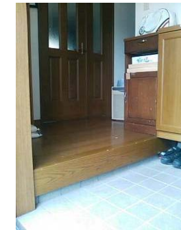
玄関の段差で下へ落ちる
