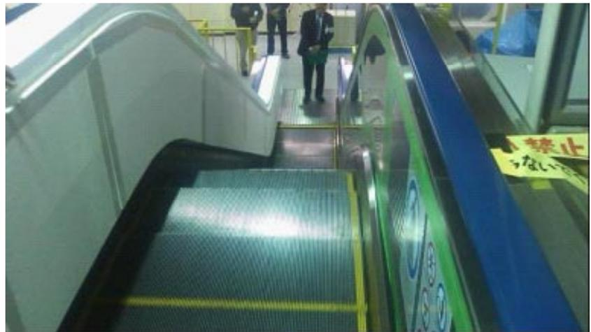
図 9. ステップと発泡スチロールの間に足が挟まらないようスカートガード部より上に設置
