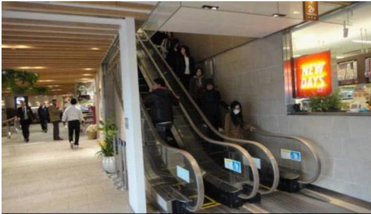
図 12. 傾斜角度 35 エスカレーター
